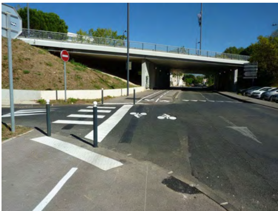
La piste cyclable doit avoir le même régime de priorité que la voie qu'elle longe. La priorité de la véloroute est ici rendue perceptible par la mise en place de figurines au niveau de l'intersection. Source : Cerema
