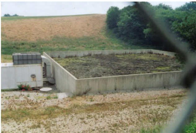
PHOTO 12 Biofiltre (effluents gazeux)
