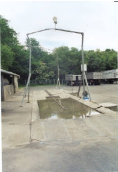
PHOTO 1 Dépôt d'Arzano (29) Aire de lavage camions et rotoluve
