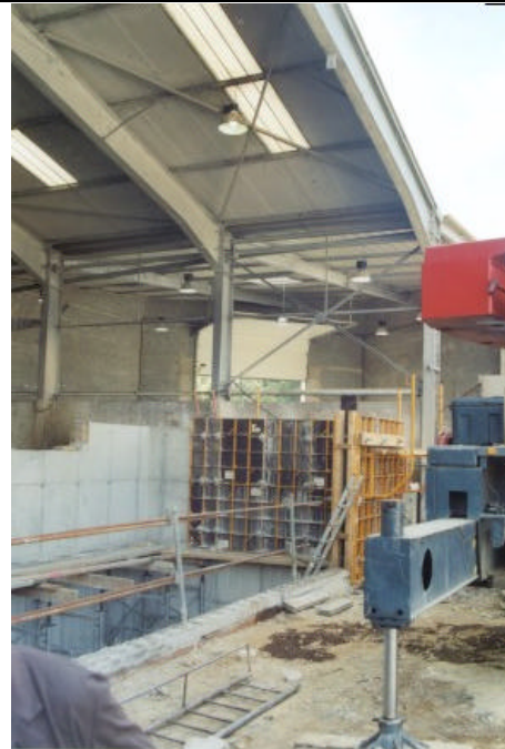
PHOTO 7 Nouvelle trémie en construction
