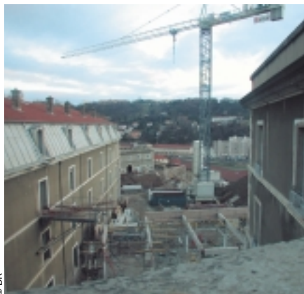
Chantier de l'ENT - LYON
