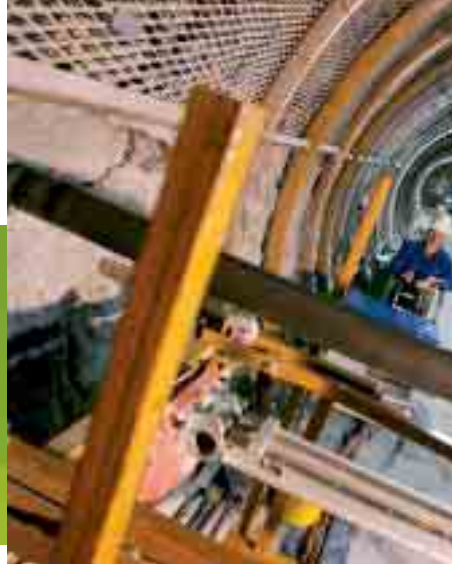
Forage à sec dans une galerie du tunnel expérimental de Tournemire (Aveyron).
