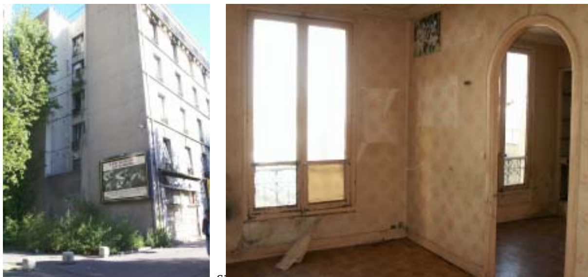
Figure 1 : Site d'étude : vues extérieure et intérieure
