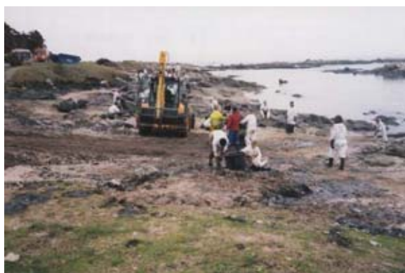
Mauvaise utilisation d'un engin favorisant le mélange des hydrocarbures et du sable, qui sera extrait à terme
