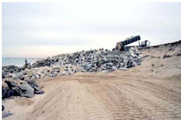
Création d'accès pour la traversée de la dune grise par des poids lourds
