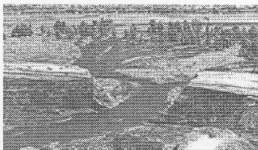
La digue après la rupture
