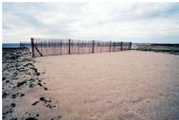
Accès sur dune, mise en place de ganivelles sur le sable nu
