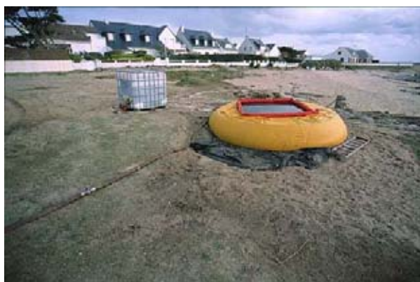
Décapage d'une dune perchée pour l'installation d'un réservoir d'eau
