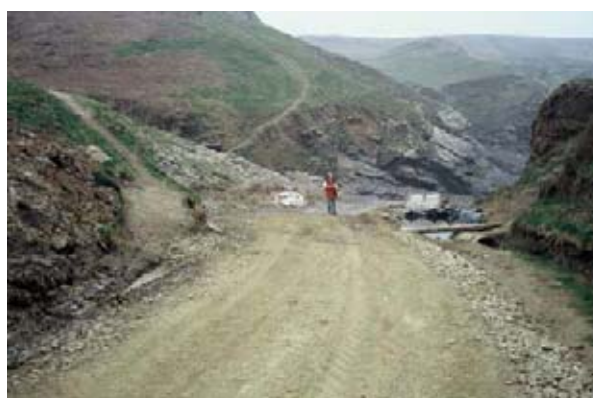
Accès élargi et remblayé pour permettre la circulation des engins
