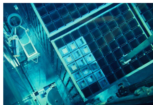
Piscine de refroidissement (EDF Belleville)
