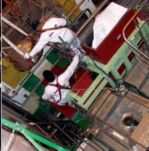
Le chantier de rénovation du réacteur expérimental CABRI.
