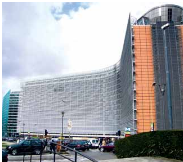
Le bâtiment de Berlaymont, le siège de la Commission européenne.
