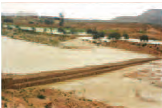
Ouvrages de recharges des nappes en Tunisie
