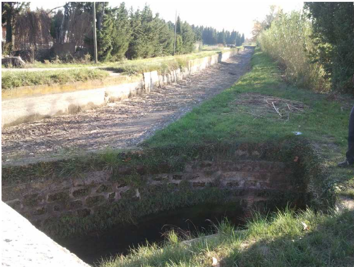
Photo 5: L'aval du partiteur de Bessière en période de chômage (à gauche la branche Tarascon; à droite la prise vers la branche de Barbentane avec sa vanne de réglage du débit)
