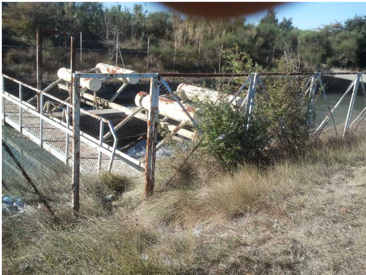
Photo 9: Vanne Amil située sur la branche d'Orgon à l'aval de la prise du canal du Moulin, symbole du vieillissement des ouvrages
