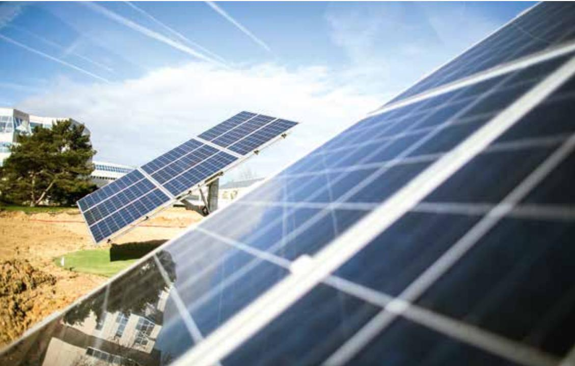
► La technologie des trackers offre un prix de revient de l'électricité produite bien inférieur à celui de toutes les autres technologies innovantes proposées dans le cadre de l'appel d'offres PV 250+. Ferme solaire sur le site Challenger de Bouygues. Panneaux photovoltaïques s'orientant en fonction du soleil.
