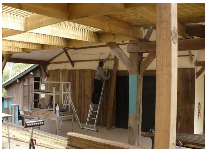
Mise en place d'un bardage en bois sur un bâtiment déjà construit (photo avril 2012, camping Le Panorama)
