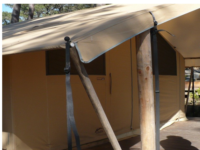
Tentes installées sur plate-forme démontable en bois (photo avril 2012, camping Le Petit Nice)
