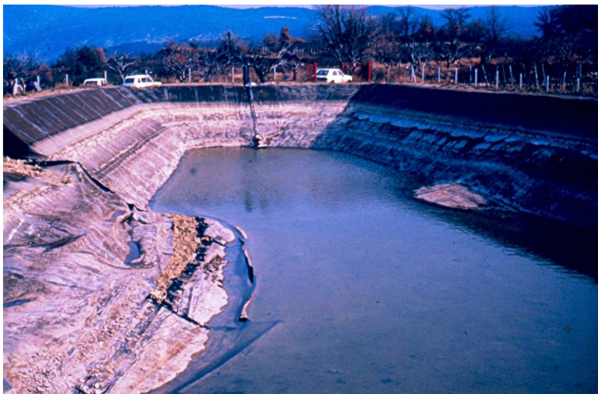
Illustration 1: Glissement de talus d'un bassin étanché par géomembrane
