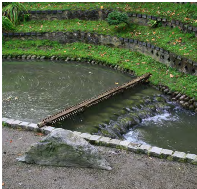
Ci-contre le système de dégrillage en cannes de bambous issues du jardin Photo datant du 16.09.11
