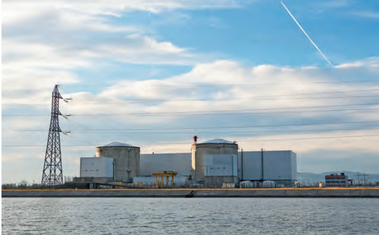
•→ L'IRSN a réalisé des études pour apprécier l'efficacité d'un épaississement du radier actuel pour les réacteurs de la centrale de Fessenheim (Haut-Rhin).
