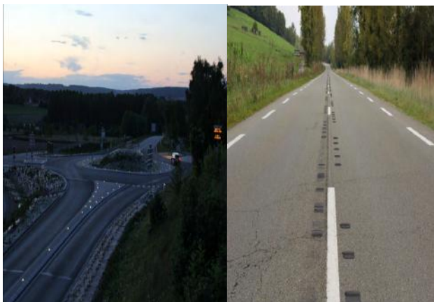
(A gauche) Giratoire RD490/RD131 (A droite) Chaussée mono-déversée
