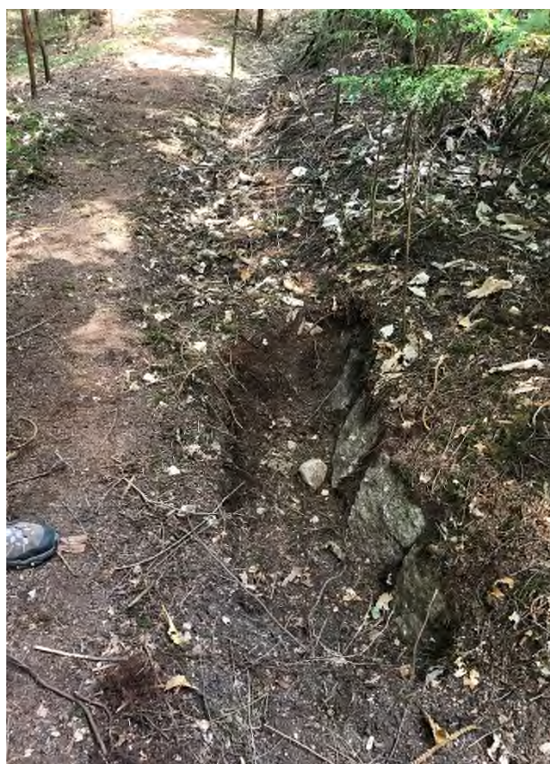
Caniveau ancien enfoui sous l'humus – Photo OS
