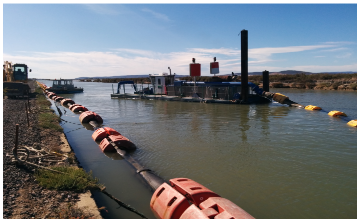
Figure 23 : La drague aspiratrice de VNF en marche avec la conduite flottante pour refouler le mélange eau sédiments dans les casiers. Source mission.
