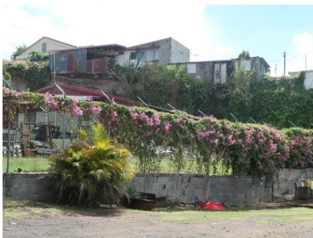
effondrement des maisons, Basse-Terre (Guadeloupe)
