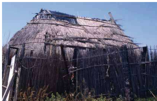
Barraca traditionnelle au bord de l'étang de Salses. Ils s'agit d'une construction vernaculaire en roseaux servant d'abri pendant la saison de pêche. Situées sur le domaine public maritime et longtemps considérées comme habitat insalubre, la plupart ont été détruites.
