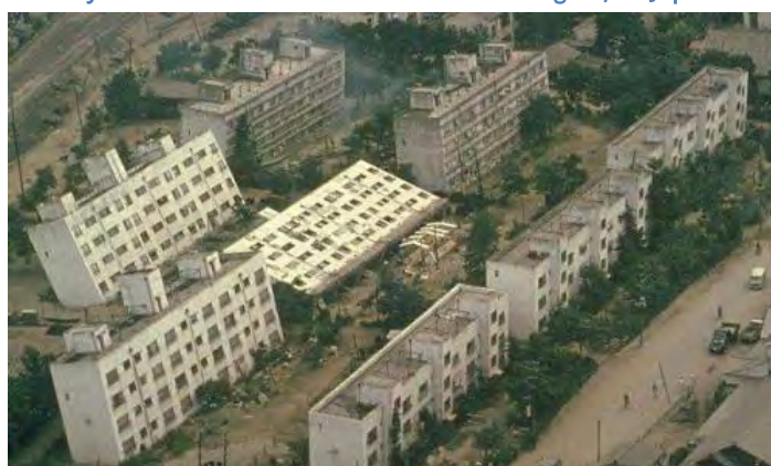
Illustration n°3 : Exemple d'effet de la liquéfaction des sols : immeubles ayant basculé lors du séisme de 1964 à Niigata, au Japon
