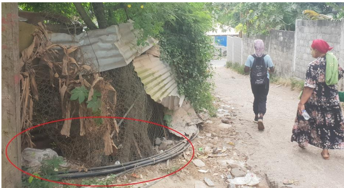
Photo n° 1 : branchement « spaghetti » à Pamanzi, Mayotte : sur un même compteur d'eau s'embranchent des dizaines de « sous-tuyaux » partant alimenter des bangas (cabanes en tôle).
