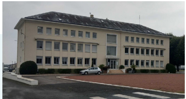
Travaux d'isolation (financés par le plan de relance) sur le commandement du soutien opérationnel de la gendarmerie nationale à Le Blanc (36)
