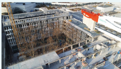
Acquisition du terrain de la nouvelle cité administrative d'État de Lyon (69) et début des travaux (livraison prévue début 2024)
