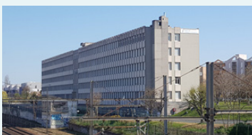
Rénovation énergétique du centre des Finances publiques de la Boudronnée à Dijon (21)
