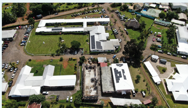
Mise en place d'une toiture solaire sur le bâtiment de la paierie à Wallis (DGFIP-Wallis et Futuna)
