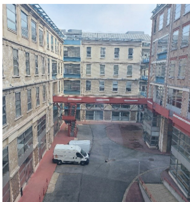
Vue sur la cour intérieure de l'immeuble
