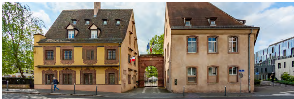
Locaux de l'INSP à Strasbourg.
