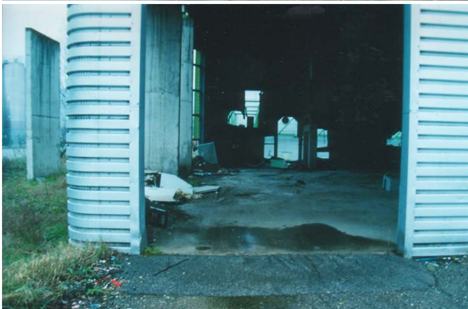
Intérieur du 1 er Bâtiment ▲
