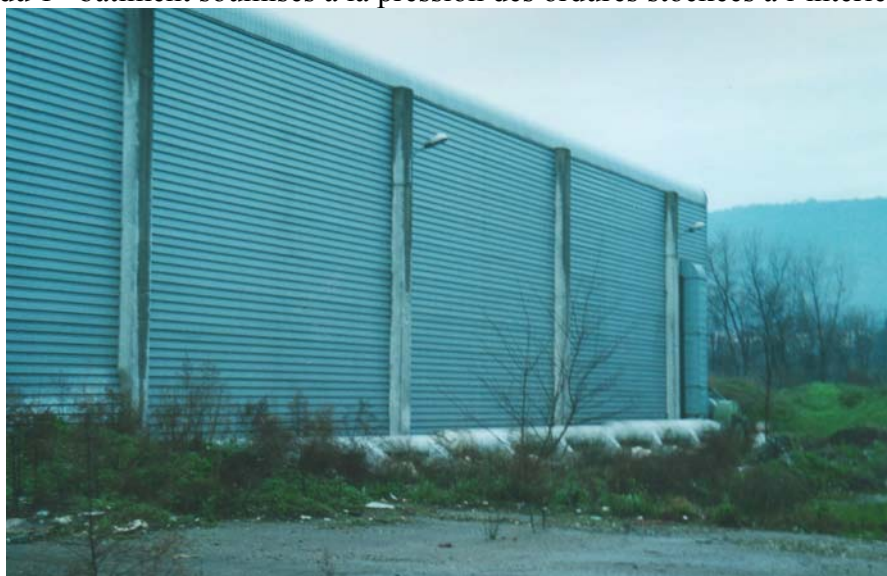
Façade nord du 2 ème bâtiment ▲
