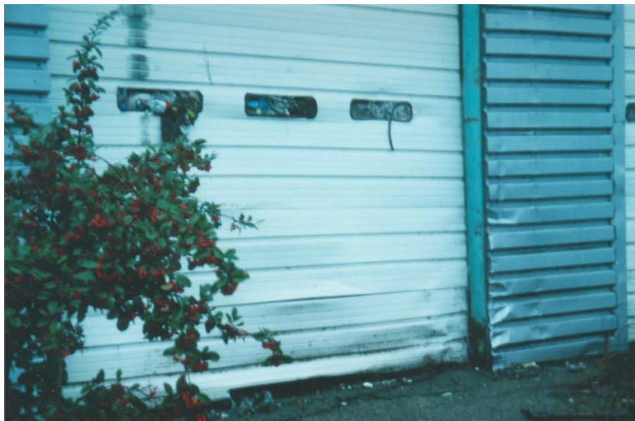
Portes du 1 er bâtiment soumises à la pression des ordures stockées à l'intérieur ▲
