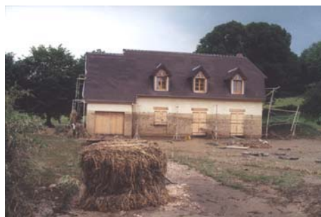
Maison en construction 46 , à l'amont, dans la rue Poncy. On distingue bien la laisse de crue.
