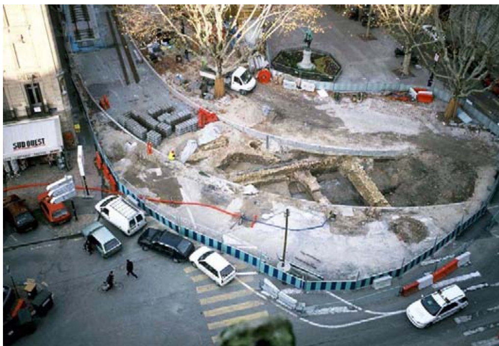
Place Jean-Moulin. Vue du chantier en cours de fouille. © W. Migeon, INRAP.
