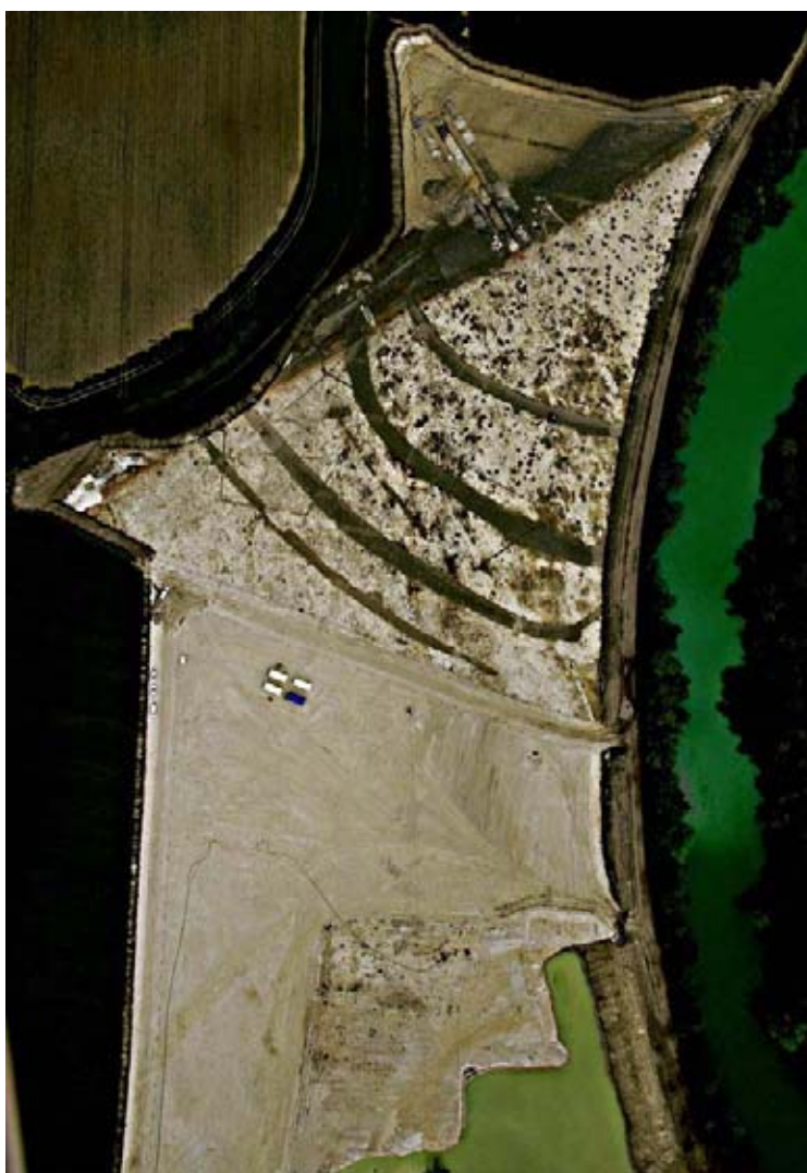
Villiers-sur-Seine. Vue aérienne du site après décapage. © J. Roiseux
