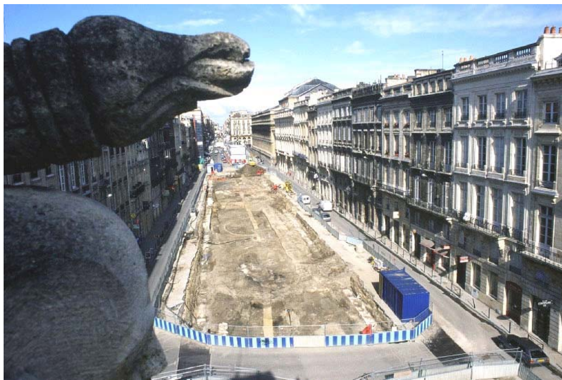
Cours du Chapeau Rouge. Vue générale du chantier. © P. Ernaux, INRAP.
