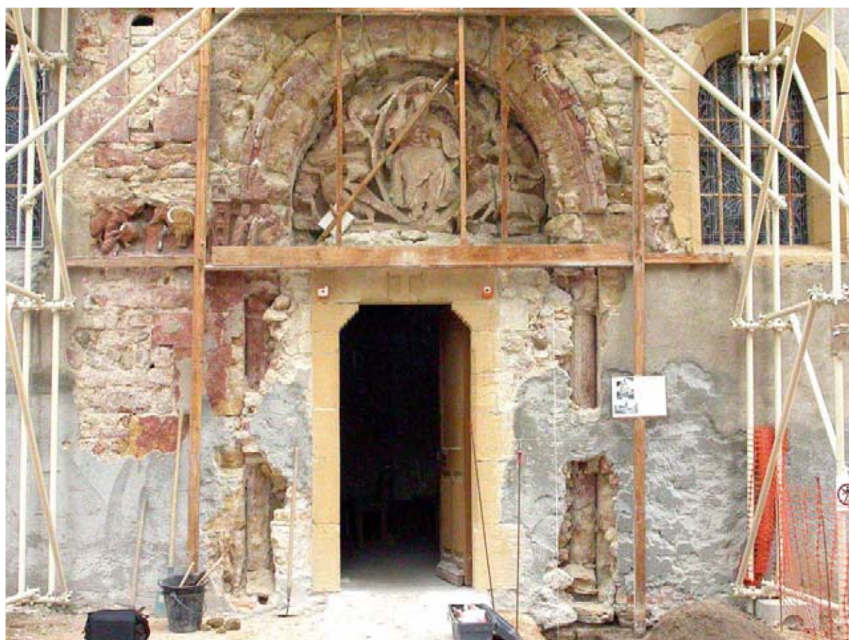
Vue générale du tympan en cours de dégagement. © C. Girardy-Caillat, SRA Auvergne.
