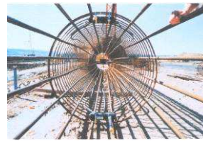
Armatures d'un pieu géothermique
