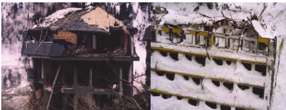
Arinsal en Andorre du 8 février 1996, Un bâtiment ravagé et le toit d'un immeuble de 6 étages
