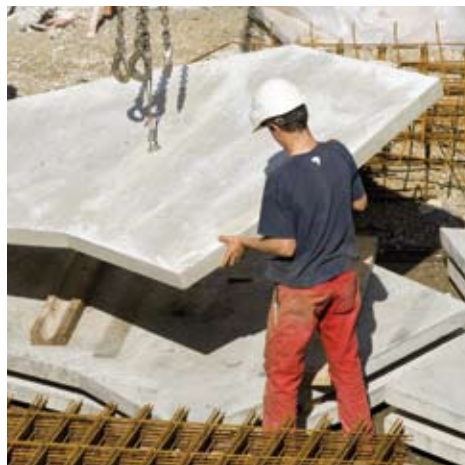
Ouvrier sur un chantier d'insertion
