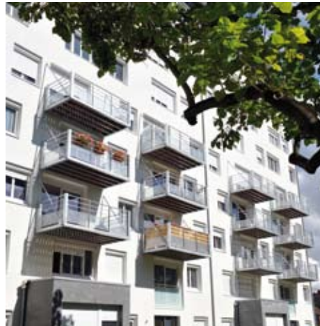
Ville de Châlons-en-Champagne, Quartier Orléans, logements réhabilités
