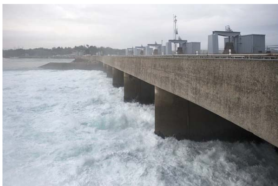
Figure 4 : L'usine marémotrice de La Rance en Bretagne (Source EDF)
