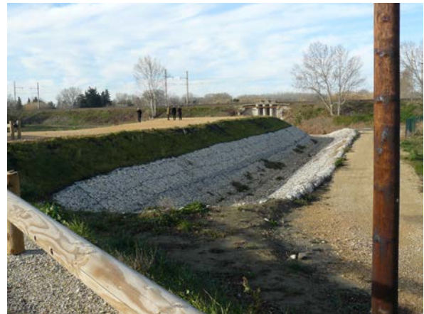
Digue nord Arles
