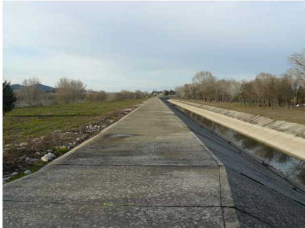
Déversoir de Vallabrègues
