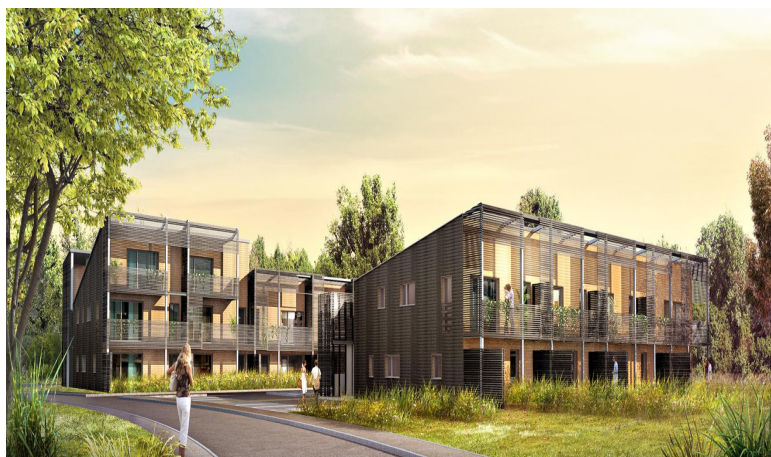
PLOEREN « Le Lain » - Construction de 28 logements collectifs Maître d'ouvrage : Bretagne Sud Habitat – Architecte Rialland et associés – Entreprise IC Bois(56)
