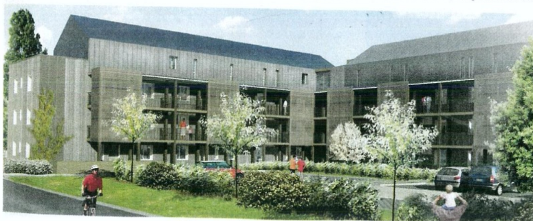
La construction de 29 logements sociaux BBC (Le Cadran) à Bruz (Ille-et-Vilaine) s'achèvera en novembre, pour un prix de vente aux primo-accédants de 1900 euros TTC/m 2 (TVA à 5,5%).
