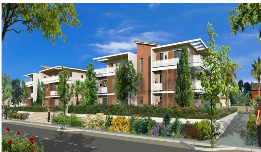
Mauguio – Le Paradou - 33 logements - Maître d'ouvrage Hérault Habitat – Architecte Namer Entreprises Groupement Demathieu & Bard
