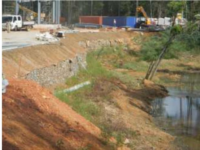
Fig. 11. AMÉNAGEMENT DE BERGE EN GABION LE LONG DE LA CRIQUE BALATA, DERRIÈRE LE FAMILY PLAZZA
