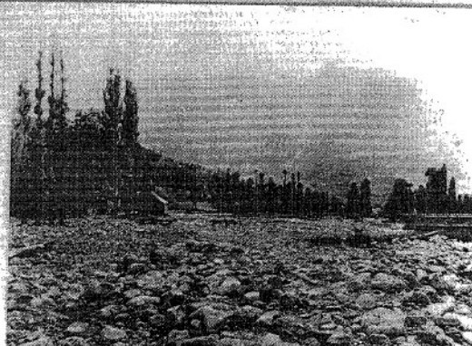
VIII. — La Chue de 1897. — La Route détruite, l'ancien ponton et le ponton détruit.
