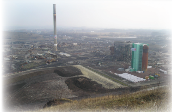
AVANT : le site METALEUROP dans les années 2000... le plus vaste chantier de dépollution d'Europe
