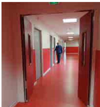
Porte coupe-feu de recoupement (couloir)
