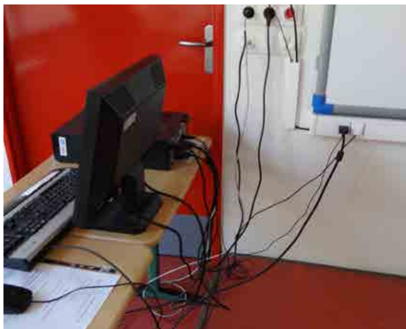
Salle de classe : risques apparents de chute d'objet, mauvaise ergonomie du poste de travail...
