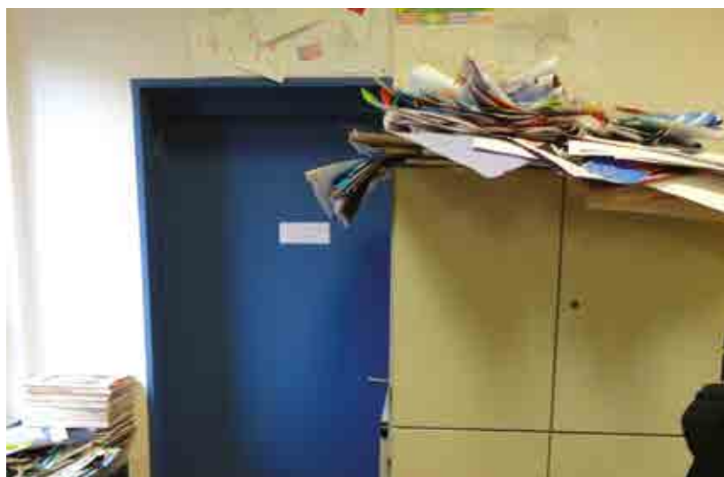
Salle d'art plastique : risques apparents de chutes d'objets, encombrement des circulations et des issues...
