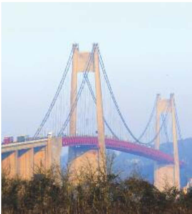
# VUE DU PONT SUSPENDU DE TANCARVILLE QUI FRANCHIT LA SEINE ENTRE TANCARVILLE ET LE MARAIS-VERNIER
