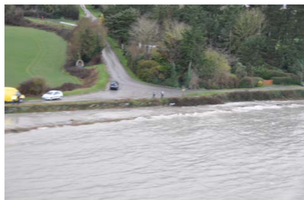
Chateau Richeux : entre 20 et 40cm sur la digue
