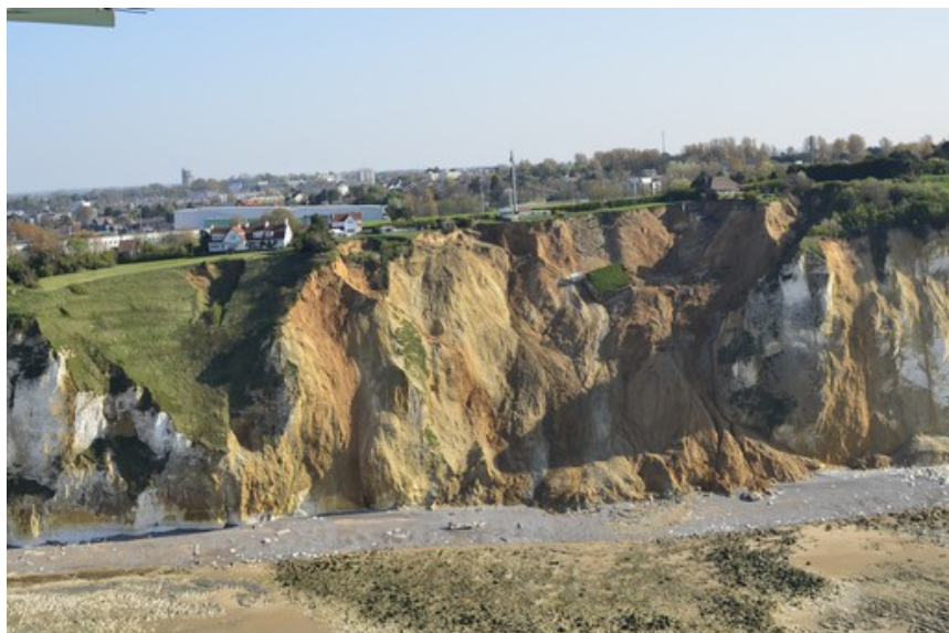
État de la falaise de Pourville en 2014 (photo BRGM). On voit dans le bas de la photo la trace de l'éboulement dont les matériaux ont été presque entièrement évacués par la mer.
