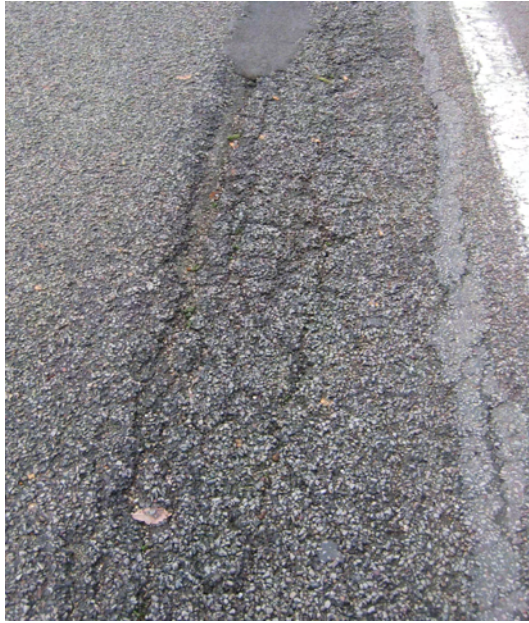
Faiénçage du revêtement dans une bande de roulement
