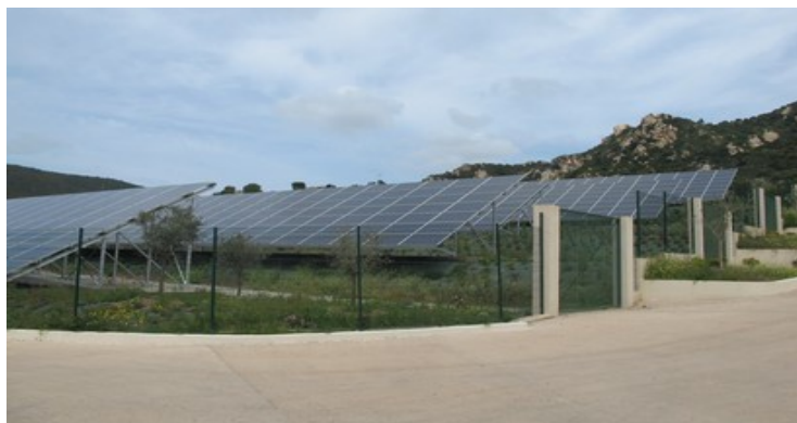
Figure 41. Vue partielle du champ photo-voltaïque
