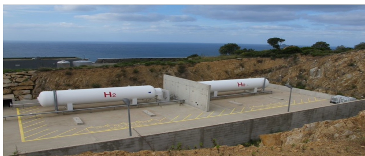
Figure 42. Les deux réservoirs d'hydrogène
