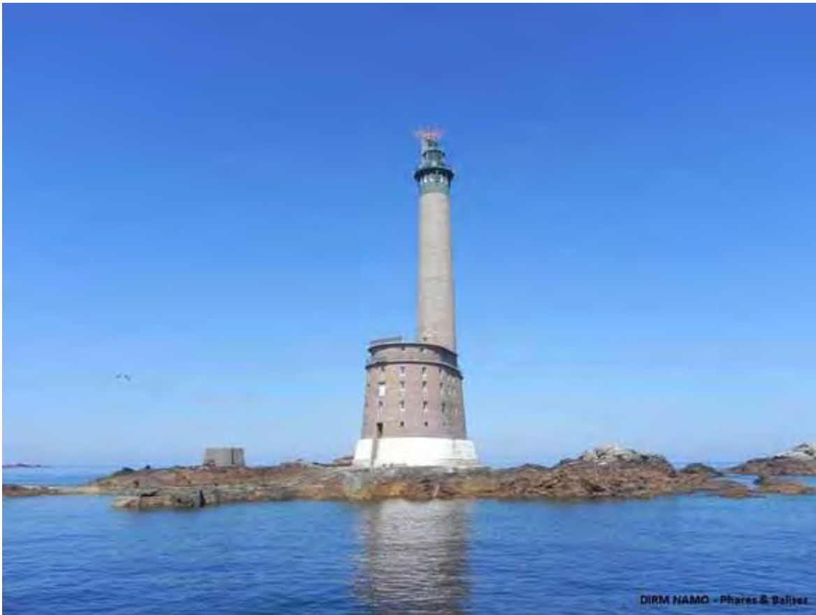
Le phare des Roches-Douvres (Côtes d'Armor), il remplace une tour métallique érigée en 1867 et détruite par les allemands en 1944. On procède à son allumage en 1954 après 7 ans de travaux ; le logement des gardiens comporte 5 étages et pas moins de 74 fenêtres. Photo DIRM NAMO
