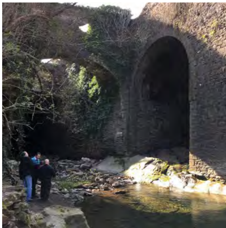
Confluence des deux ruisseaux couverts voûte effondrée sur l'Oguène 1 et mauvais état du subsistant (photo mission)
