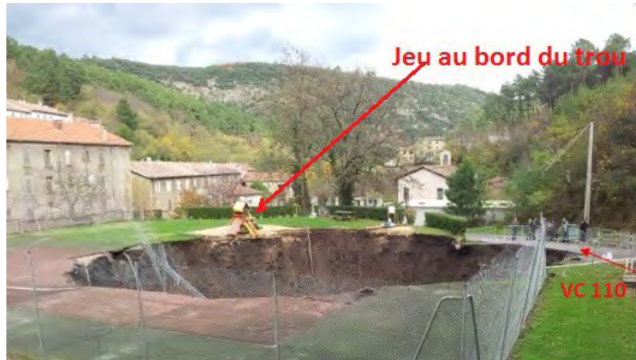
Effondrement de Rochessadoule en novembre 2012
