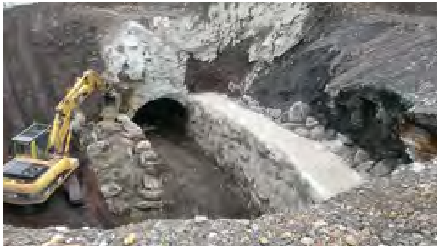
Chantier de reconstruction de la partie effondrée
