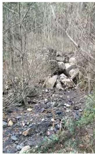
Ouvrages hors d'usage : gabions explosés, bassin de rétention des sédiments saturé...
