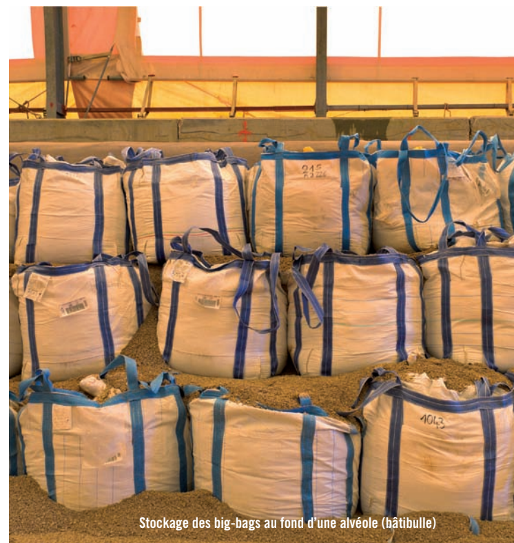
Alvéoles de stockage du CSFMA
