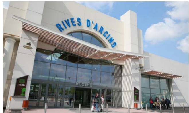
Rénovation Rives d'Arcins Photos Klepierre
