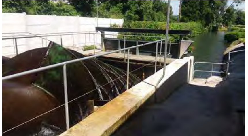
L'usine principale, avec de gauche à droite : passe à anguilles, passe à bassins multi-espèces, vis d'Archimède (ichtyocompatible)
