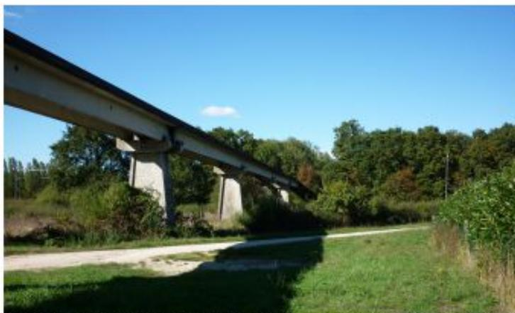
Malgré quelques slogans et peintures diverses, l'ouvrage encore sur pied ne présente pas d'anomalies visuelles agressives. L'intégrité de la structure est quasiment intacte.
