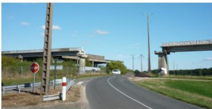
L'intervention curative suite à la rupture des câbles de tension a rompu le lien du viaduc avec le station. Si des opérations curatives ou préventives sont à envisager, il faut qu'elles puissent s'opérer sur des sections courtes pour limiter une atomisation trop grande de l'ouvrage.
