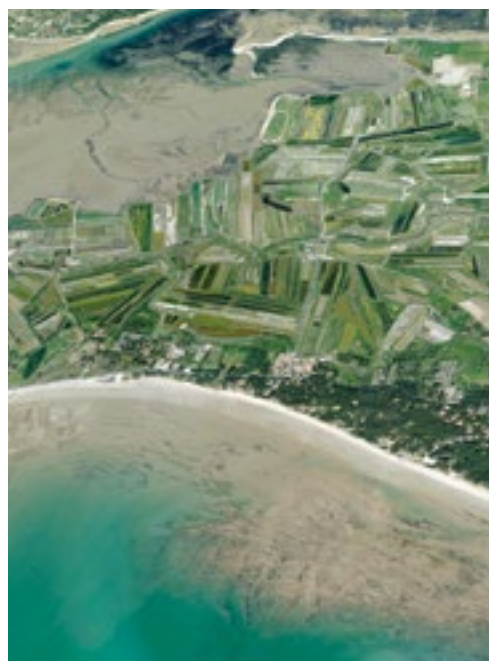
Projet de renforcement de la digue de La Couarde-sur-Mer
