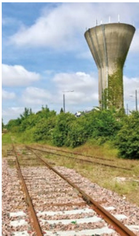
Ligne ferroviaire Orléans - Châteauneuf-sur-Loire
