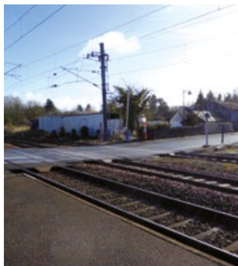
Suppression de passages à niveau à Neau et Brée et contournement nord de Montsûrs
