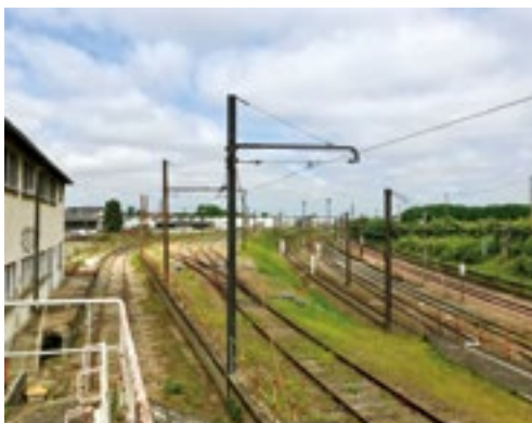
Ligne ferroviaire Orléans - Châteauneuf-sur-Loire
