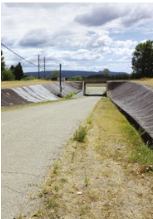
Digue à l'ouest du remblai ferroviaire entre Arles et Tarascon
