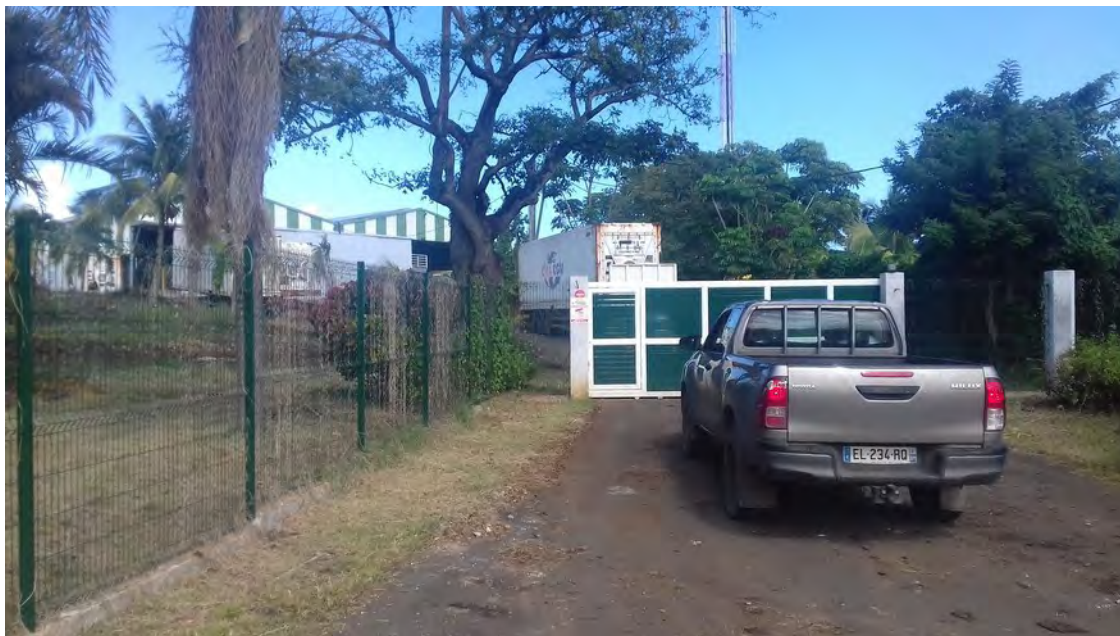
Photo n° 5 : porte fermée pour l'accès à des ouvrages du feeder BEC (source : mission.)
